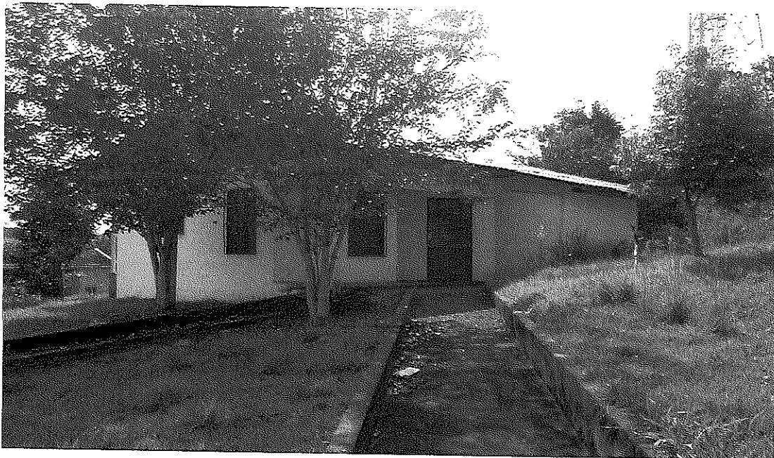
Figura 2 – Lateral do imóvel
